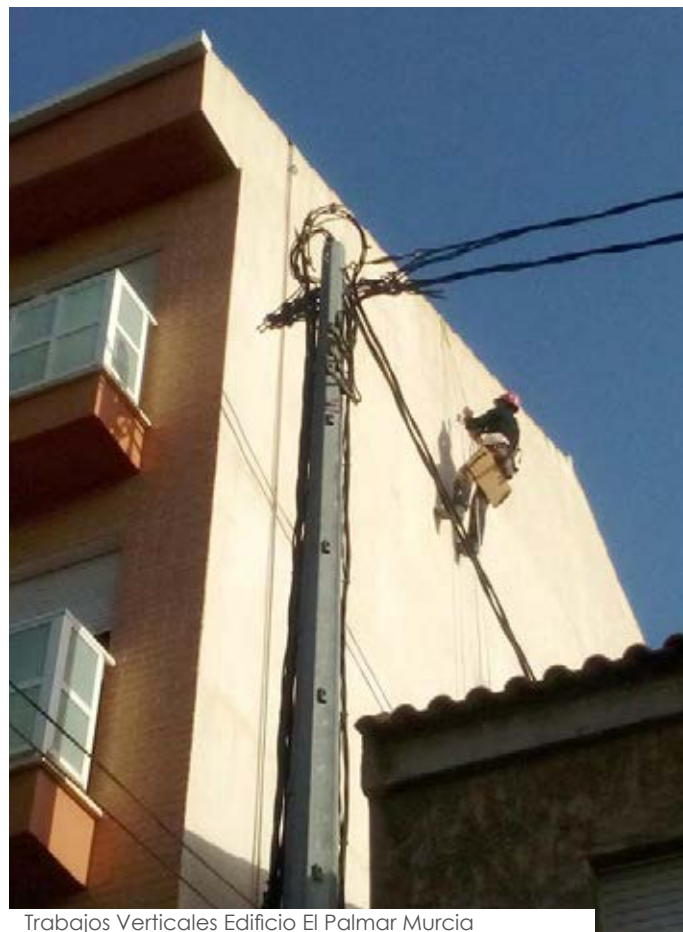
Trabajos Verticales Edificio El Palmar Murcia
