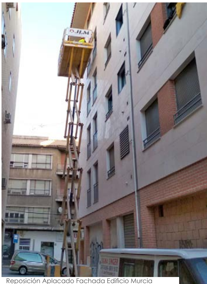
Reposición Aplacado Fachada Edificio Murcia
