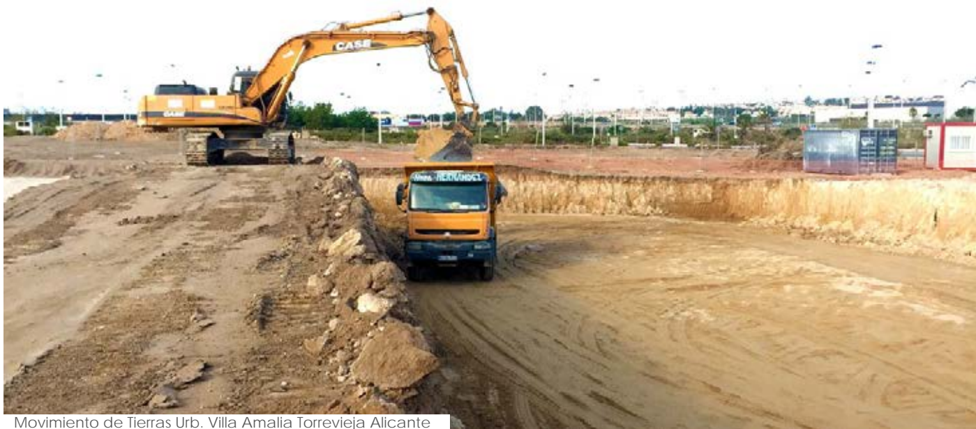
Movimiento de Tierras Urb. Villa Amalia Torrevieja Alicante
