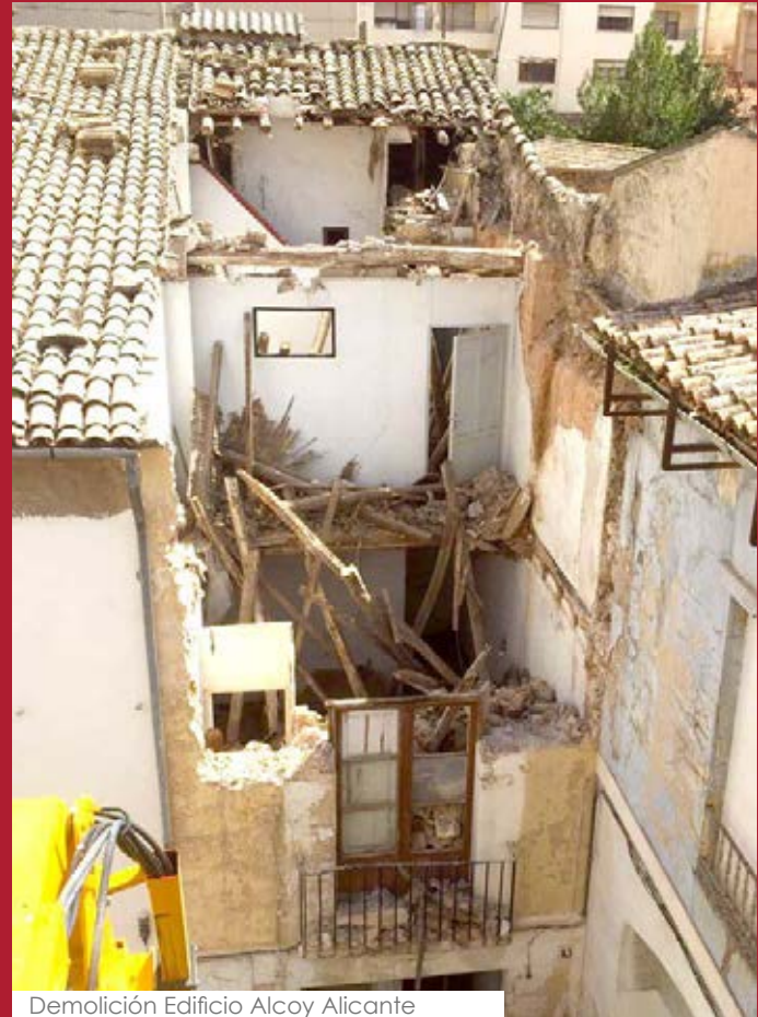
Demolición Edificio Alcoy Alicante
