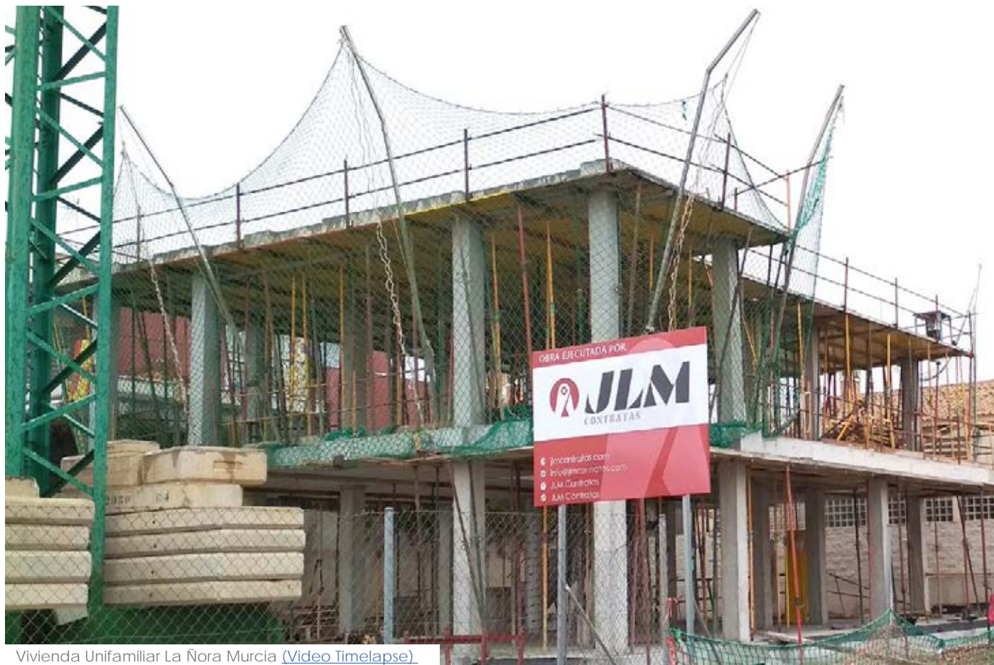
Vivienda Unifamiliar La Ñora Murcia ( Video Timelapse )
