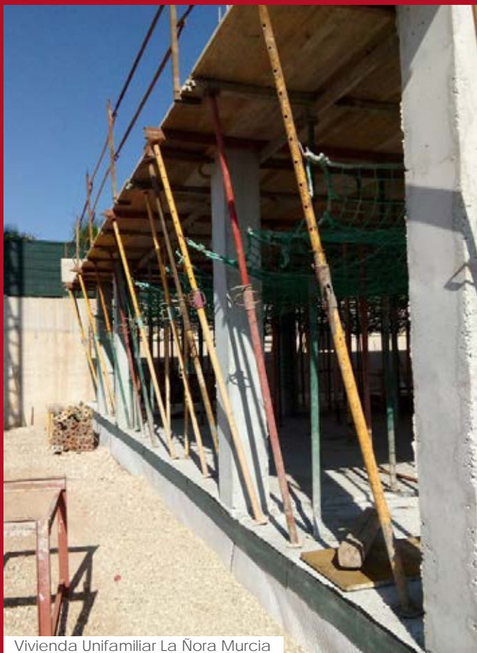
Vivienda Unifamiliar La Ñora Murcia
